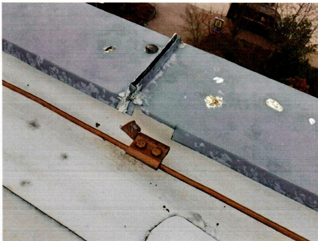
Foto.č.3: Utržené kotvení hromosvodu na oplechování atiky, rozpojení spoje oplech.
